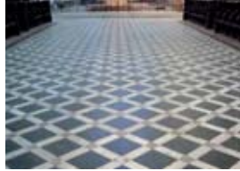
Laons, Cattedrale, 1253, lavori di restauro del XIX secolo, pavimento lapideo del coro. Laons Cathedral, 1253, restaurating work XIX century, marble pavement of the choir.
